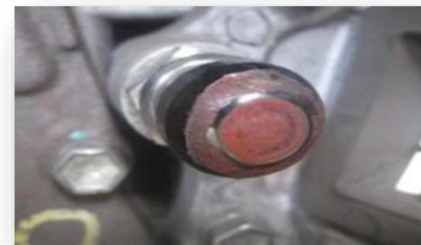
Đầu chốt tì bị Qmòn do mỡ bôi trơn bị biến chất
